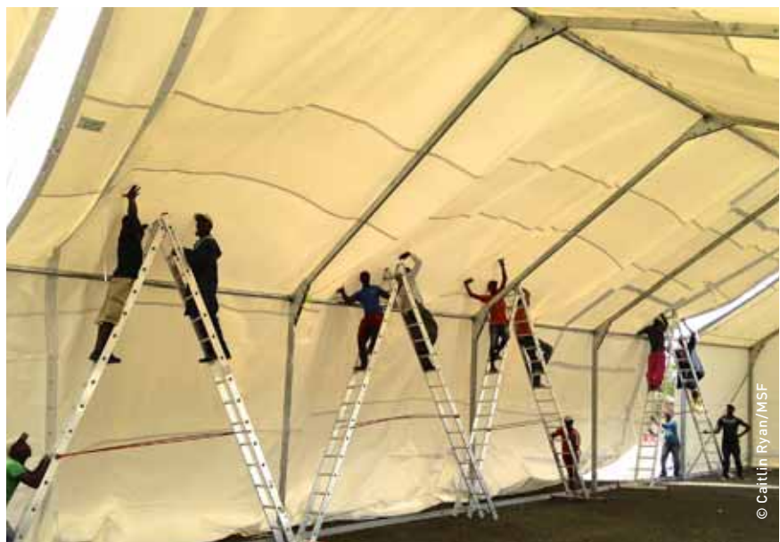
Monrovia, au Libéria. Les équipes de construction bâtissent ce qui deviendra ELWA 3, le plus grand centre de traitement d'Ebola au monde, avec 250 lits.
